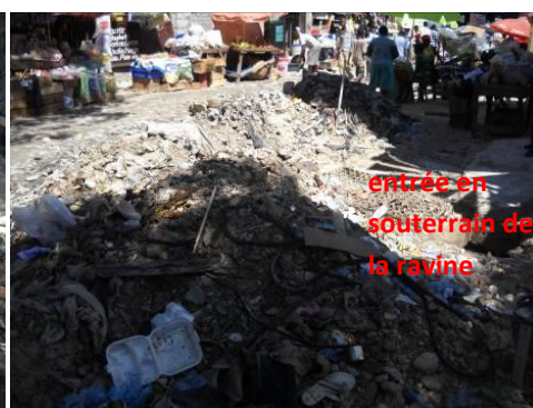
Les opérations de déblaiement permettent d'observer la grille d'entrée en souterrain de la ravine pour sa traversée du carrefour du marché
