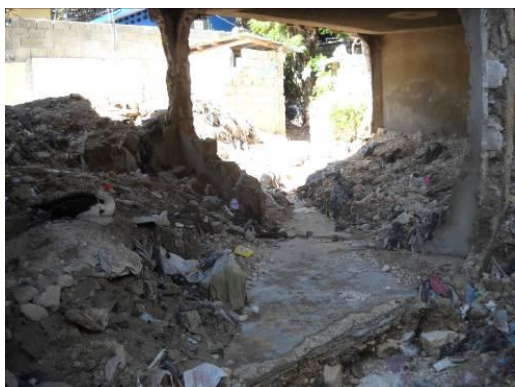
Rez-de-chaussée de maison détruit lors d'une crue de la ravine Auguste laissant la maison sur pilotis !
