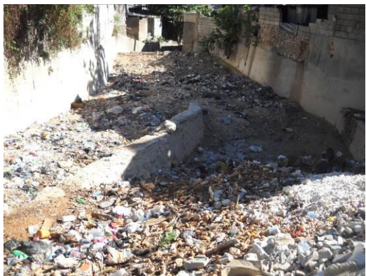
Dégraveur Bourgot sur la ravine Zonyon difficilement reconnaissable du fait de son encombrement - photo avril 2012
